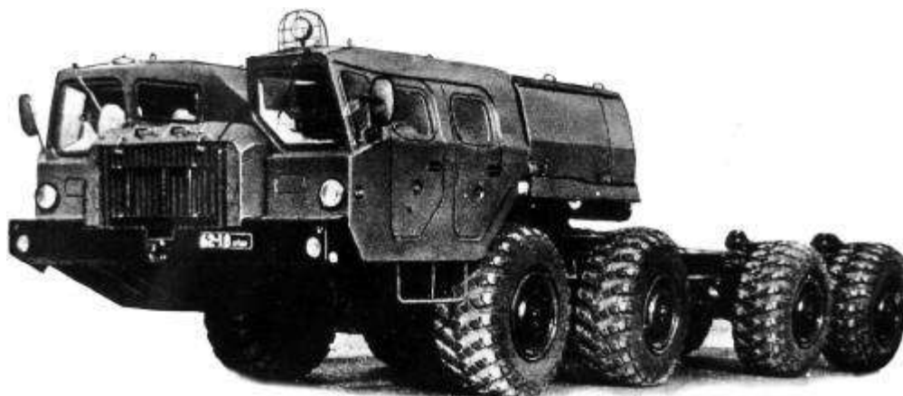
Опытное шасси MAZ-79112 для транспортно-заряжающей машины системы «Смерч»
